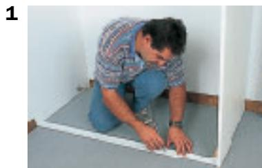
**1. Tracer l'emplacement du rail bas en fonction de la profondeur du placard.**
