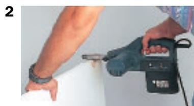
**2. Réaliser la découpe de passage de la plinthe à la scie ou à la lime électrique.**
