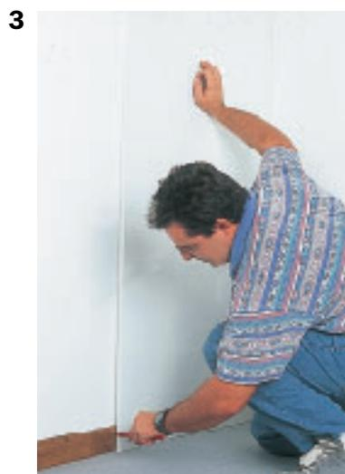
**3. Positionner la joue contre l'autre mur afin de tracer l'affleurement de la façade.**
