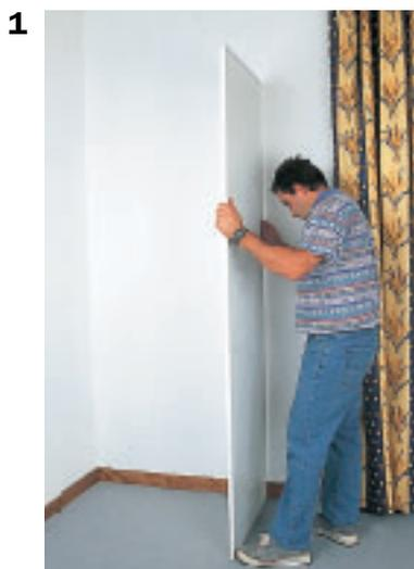
**1. Découper la joue à la hauteur et à la largeur voulues, et la présenter perpendiculairement au mur afin de tracer l'éventuel passage de la plinthe.**
